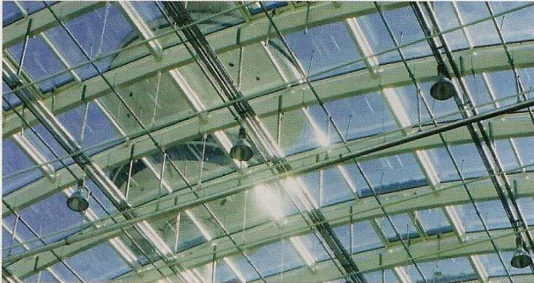
térmico y acústico; autolimpiado; seguridad, resistencia contra rotura y protección contra robos. Este sistema cuenta con perfiles de aluminio para la realización de pirámides y cubiertas de vidrio que se pueden utilizar como vigas, travesaños, dinteles o correas, además de contar con claraboyas, exutorios, etc., y la posibilidad de integrar placas solares para la obtención de energía.
